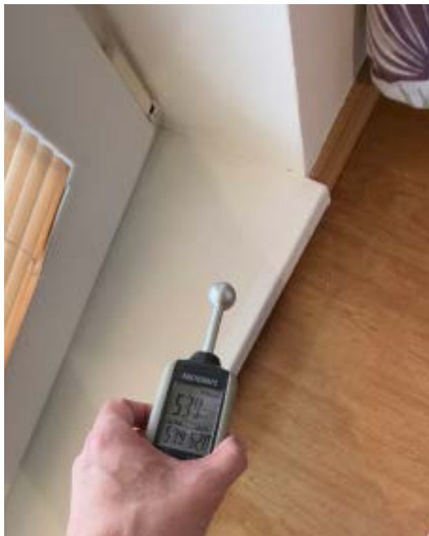
Spodní úroveň - Vlhkost 8%
