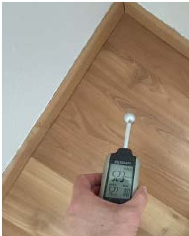
Spodní úroveň - Vlhkost 7%
