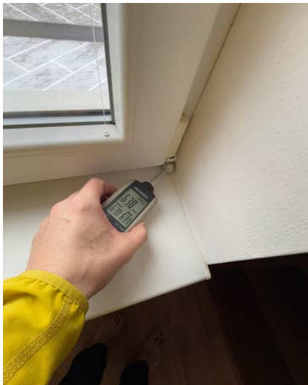
Spodní úroveň - Vlhkost 11%
